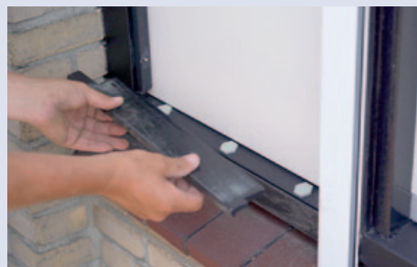
Bovenop de kliklijmpads worden de profielen geventileerd geplaatst
