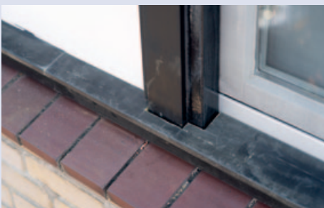
Neuslat in contramal op onderliggend hout dat eerst kaal is gemaakt om een zo dampopen mogelijke ondergrond te creëren
